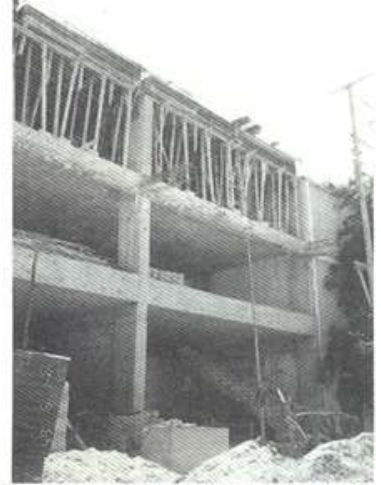
125-B, 300 Sq. Yds., Khalid Bin Waleed Road, PECHS (زیر تعمیر غیر قانونی کارشورازہ عمارت)
